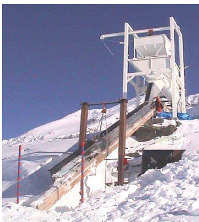
Fig. 1. The Col du Lac Blanc chute. Fig. 2. The protective bunker
